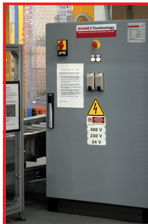
Quadro elettrico Electrical cabinet
